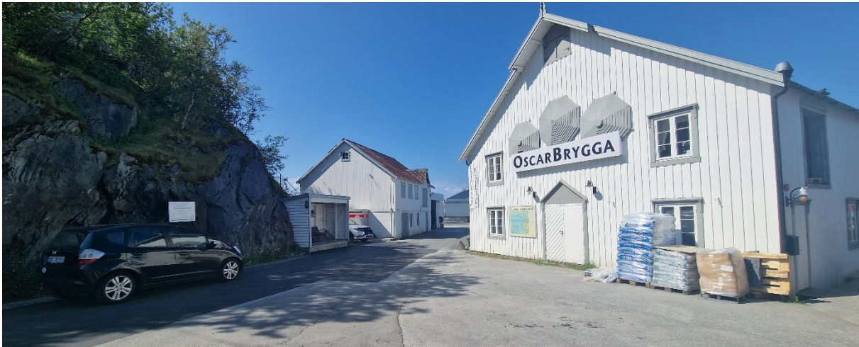
Figur 7: Bilde fra sentralt i planområdet, sett mot vest. Bildet viser "Oscarbrygga"; en restaurant og overnattingssted.
